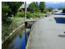
写真-1 現場イメージ (水路と道路が隣接)
